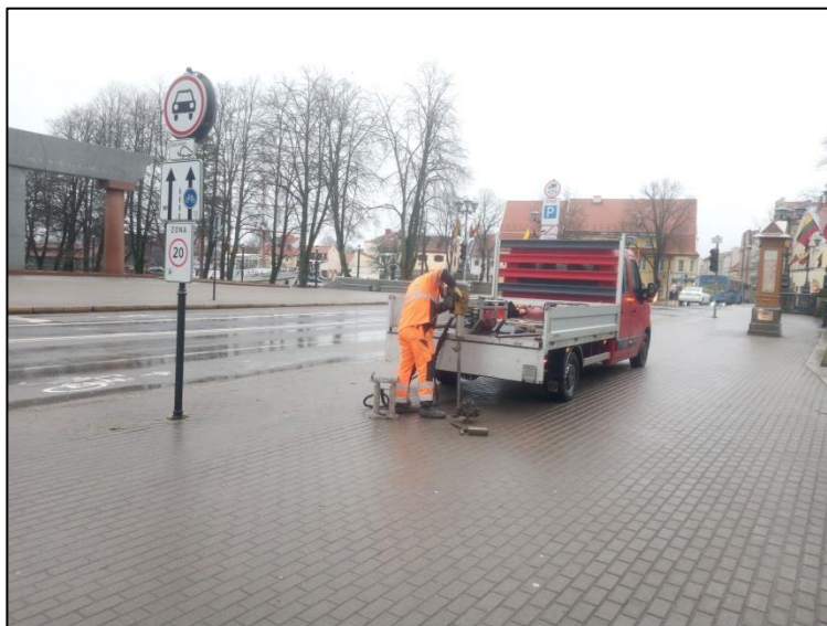
1 pav. Lauko darbai
